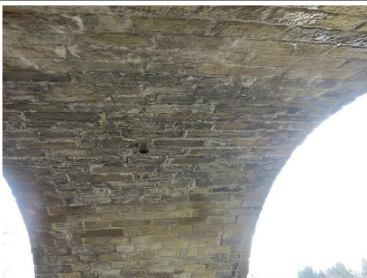
Foto č. 2 K 07 - průsaky s výluhy z pohledu konstrukce
