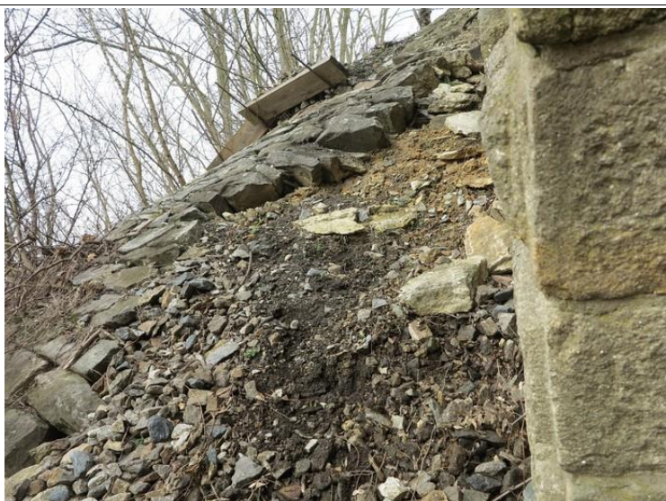
Foto č. 3 O 02 - rozvolnění kamenného kužele křídla vlevo
