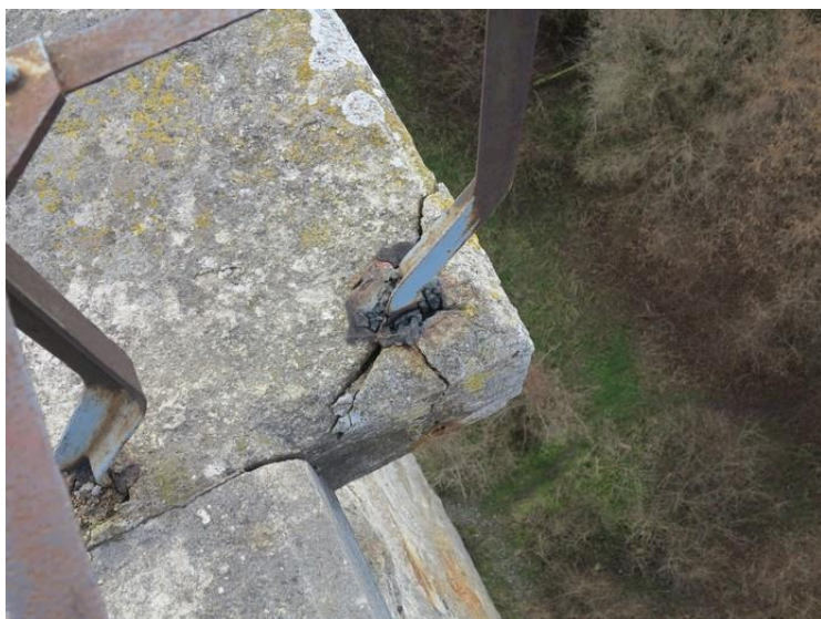
Foto č. 1 K 04 - trhliny v římse vpravo v bezpečnostním výklenku
